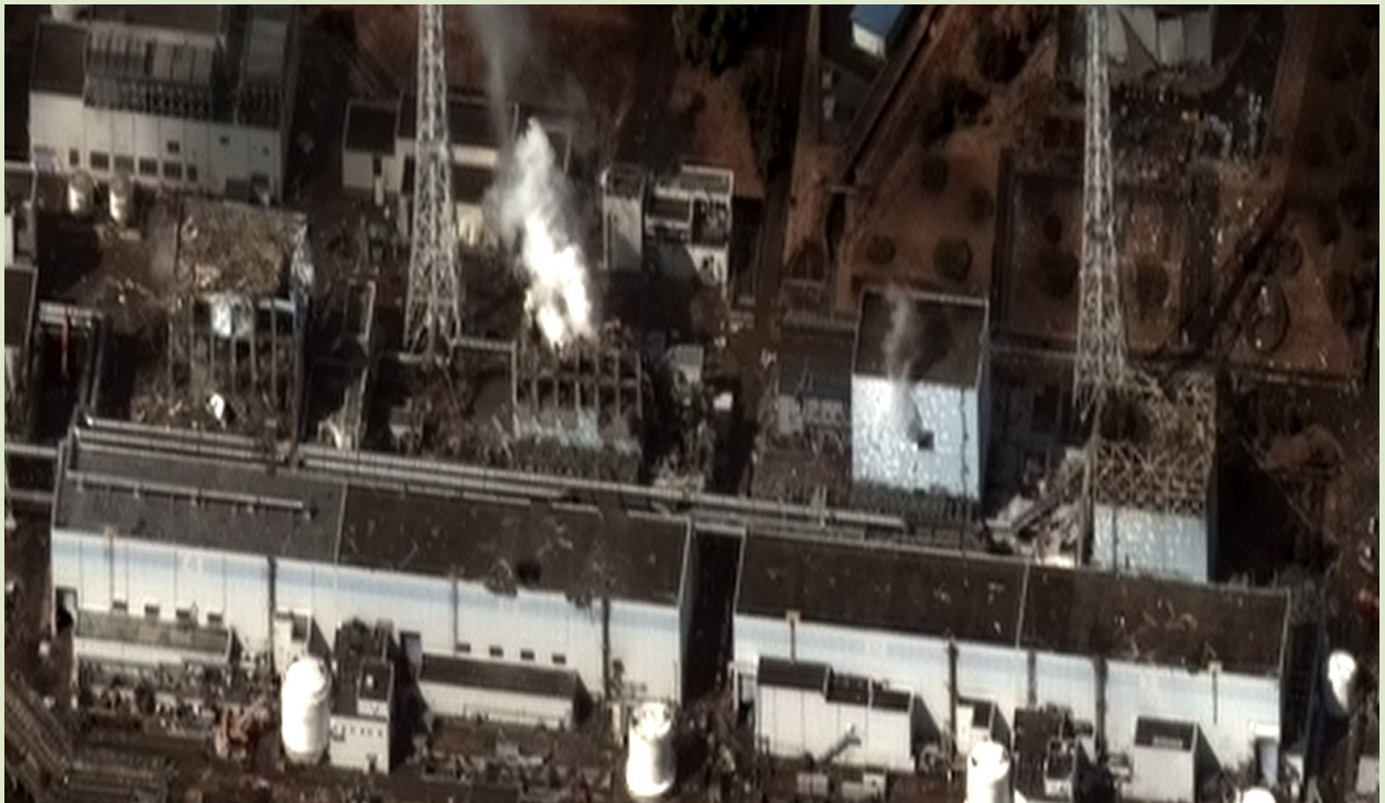
De Fukushima-kerncentrale na aardbeving en tsunami. Reactor 1-4 van rechts naar links
