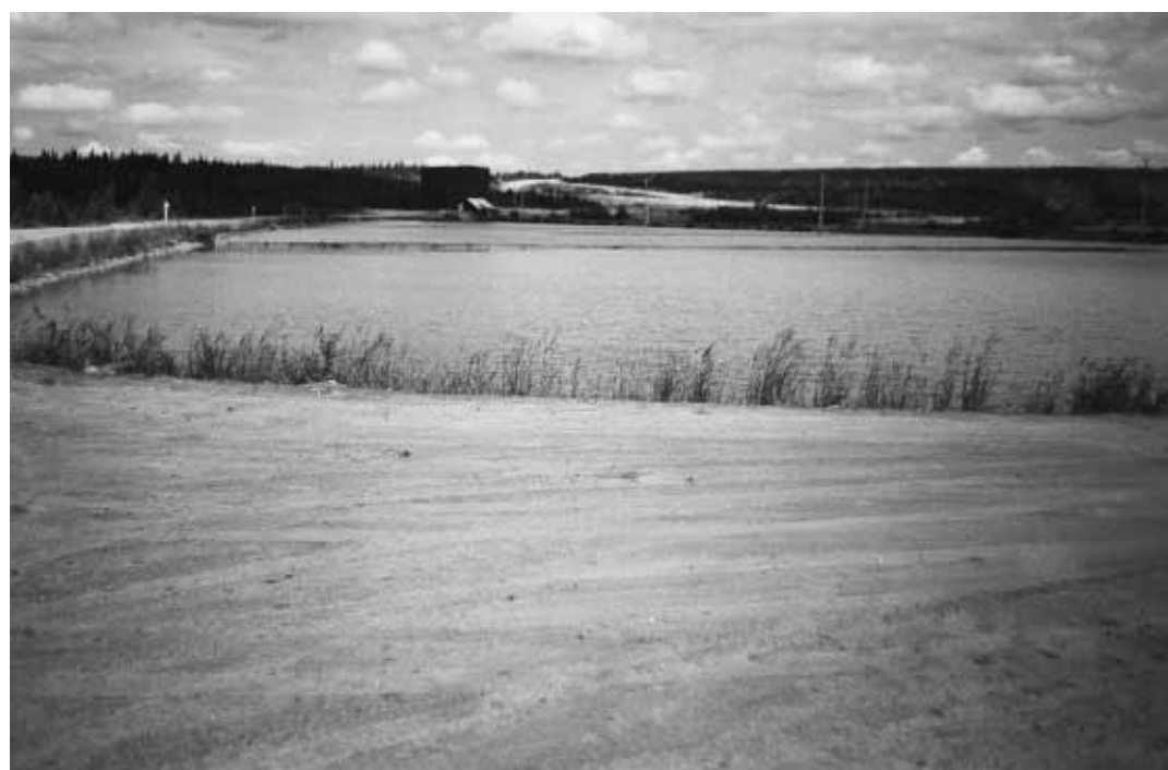
Rückstandsbecken der Key Lake Mine in Saskatchewan, Kanada
