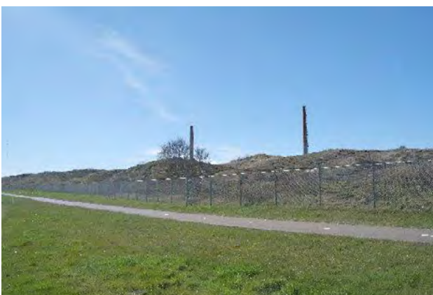
Figuur 60 Foto's zicht op OLP vanaf Westerduinweg (opname Arcadis 2016)
