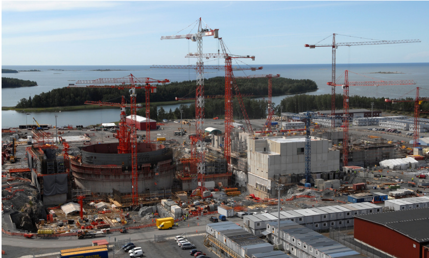
Figuur 2.6 De EPR in aanbouw in Finland Bron: TVO, juli 2007.
